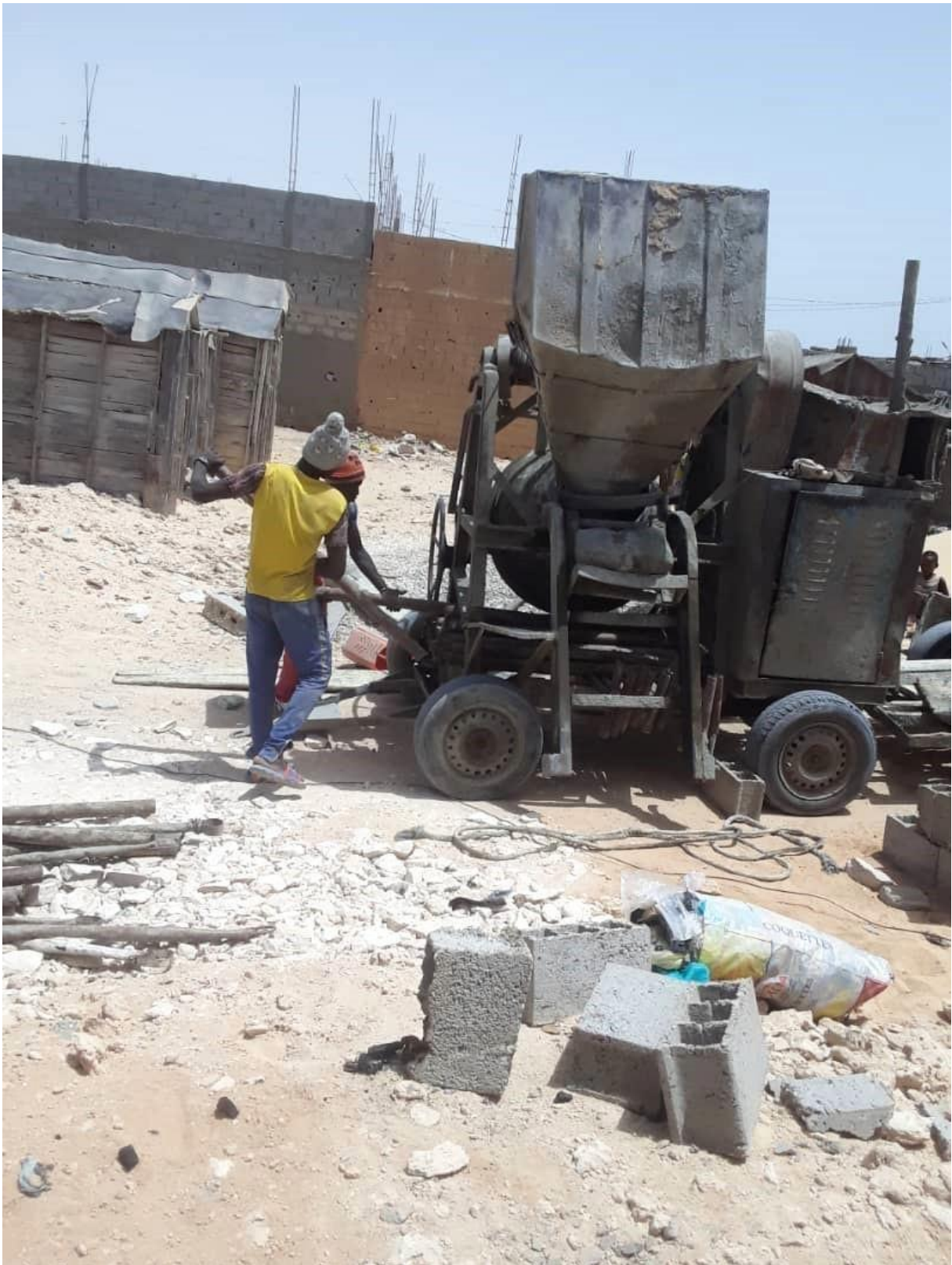
Een professionele betonmolen is gehuurd voor het storten van het plafond.
