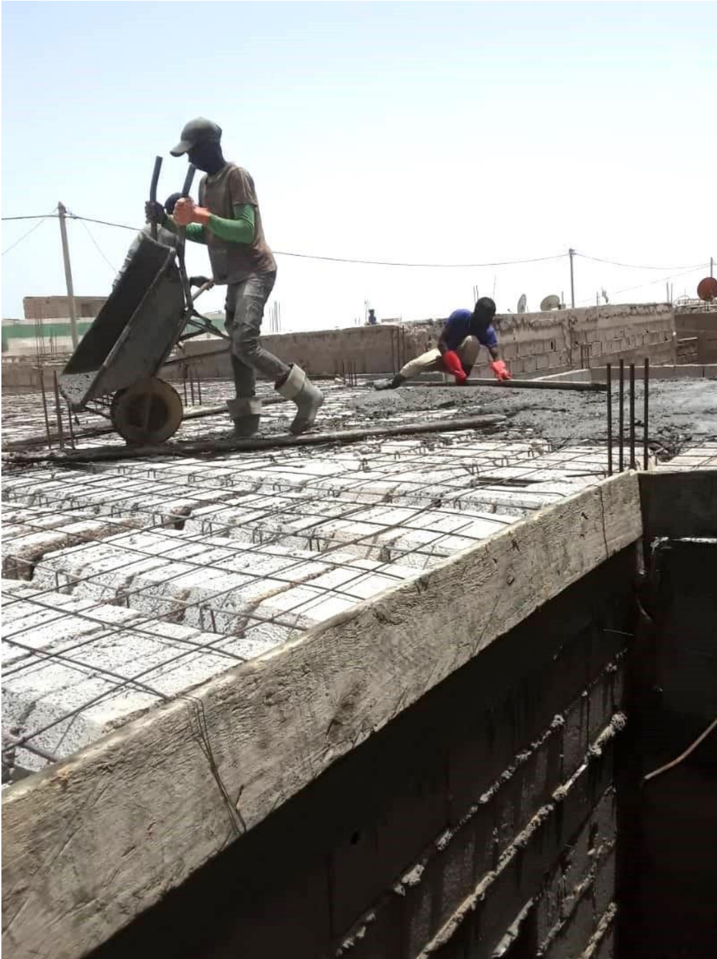
Storten van het dak voor het nieuwe gebouw.
